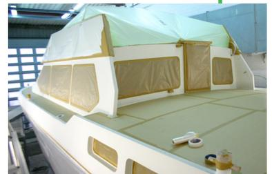
Die Grundierung wird mittels Hochdruckspritzen mit ca. 500 bar Spritzdruck lösemittelarm und dickschichtig aufgetragen (entspricht ca. 30x "von Hand") – das neue Schutzschild für das Laminat und optimaler Unterbau mit drei Jahren Garantie für die Spritzlackierung.
