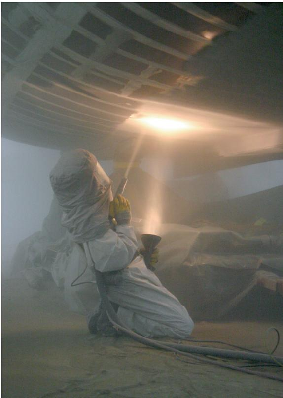
Nur der Sandstrahl erreicht selbst die tiefsten Einfressungen. Der metallisch reine Untergrund nach dem Strahlen ist der perfekte Haftgrund für das nachfolgende Spachtel- und Beschichtungssystem.
