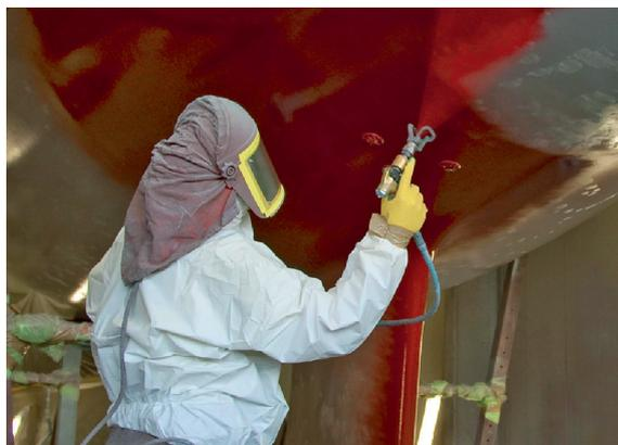
Nachdem die Strahlkante zum Freibord geglättet wurde, wird die Epoxidbeschichtung gleichmäßig und dickschichtig (etwa 400µ) in Airless-Spritztechnik aufgetragen und dieses Schutzschild bei ca. 30°C gehärtet. Ein sicherer Schutz für viele Jahre.
