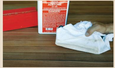
9 - Reinigen und entfetten Sie die Fugen gründlich mit einem in ein sauberes Tuch gewickeltes Spachtelmesser oder Stück Resopal. Das Tuch mit Aceton anfeuchten und häufig wechseln. Mit Vorwärts- und Rückwärtsbewegungen die Fuge reinigen. Das Aceton trocknen lassen und dann unmittelbar verfugen.
